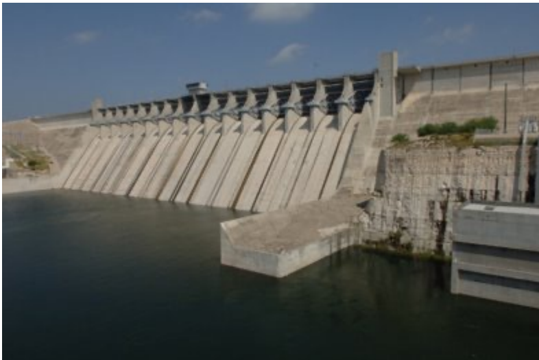
Amistad Dam - Del Rio, TX
